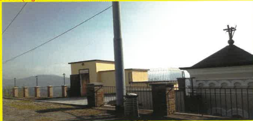
Il sito terminato. (19 Ottobre 2019)
