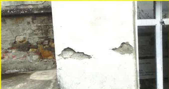
Si mise mano agli intonaci obsoleti.
