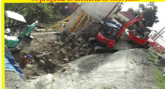
Si riprendono i lavori di preparazione.
