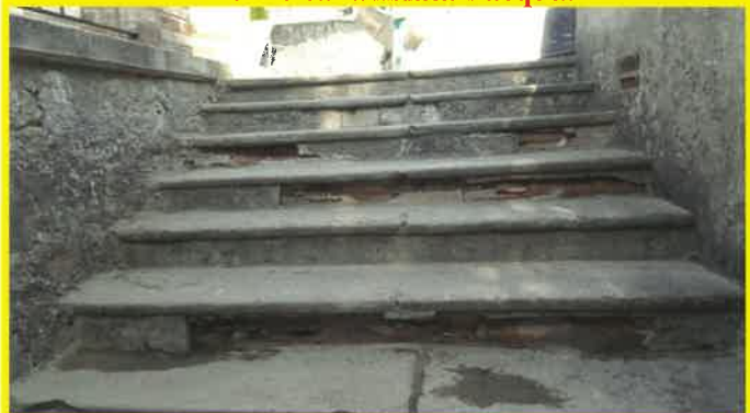
Anche la scala esterna era da ripristinare .
