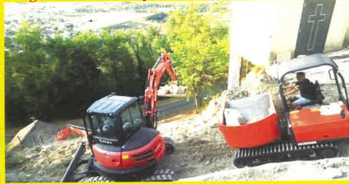
Le macchine movimento terra entrano in azione.
