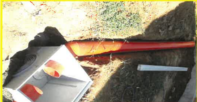
Venne canalizzata l'acqua.
