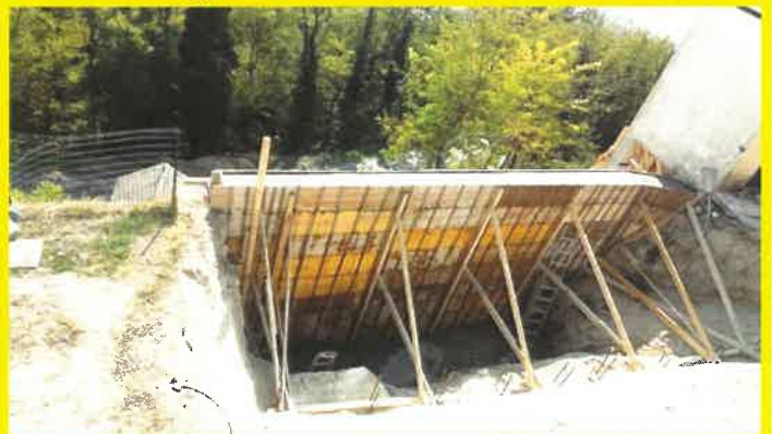
Riempendo il tutto di calcestruzzo.
