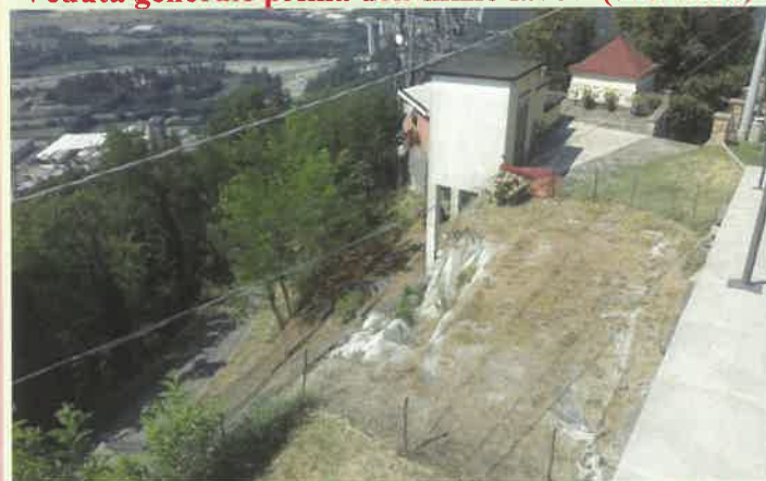
Veduta generale prima dell'inizio lavori (Dall'alto)
