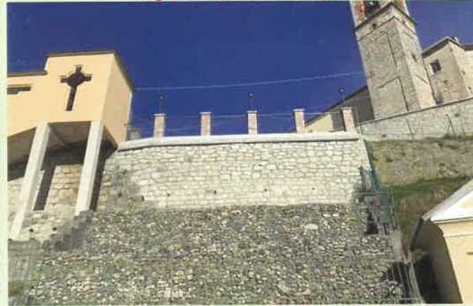
Veduta generale al termine dei lavori
