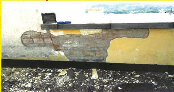
Rimuovere gli intonaci deteriorati
