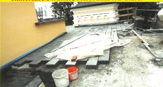
Sopra la guaina il pavimento in pietra luserna
