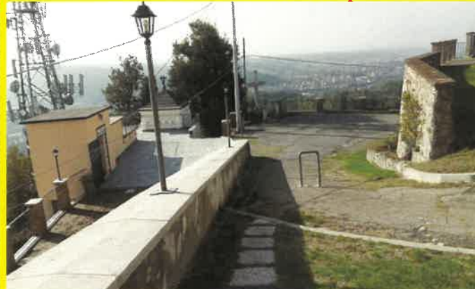
Fine lavori vista superiore: Ottobre 2019.
