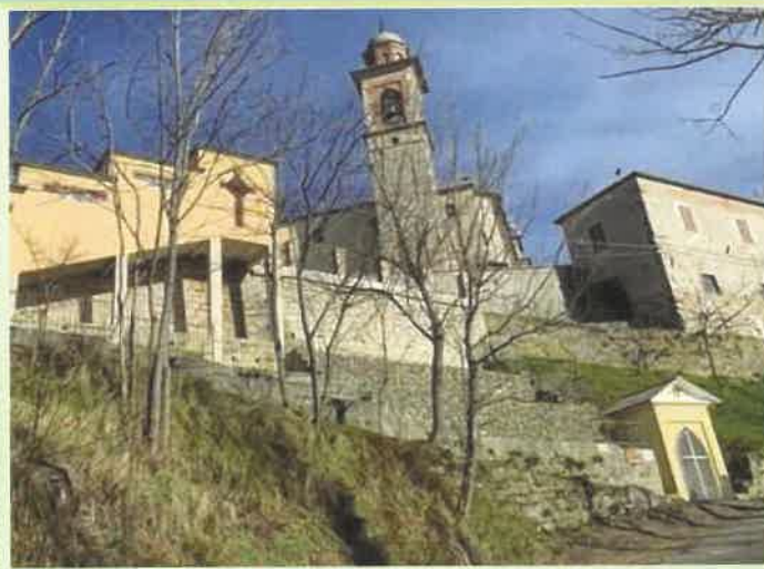
Veduta generale al termine dei lavori
