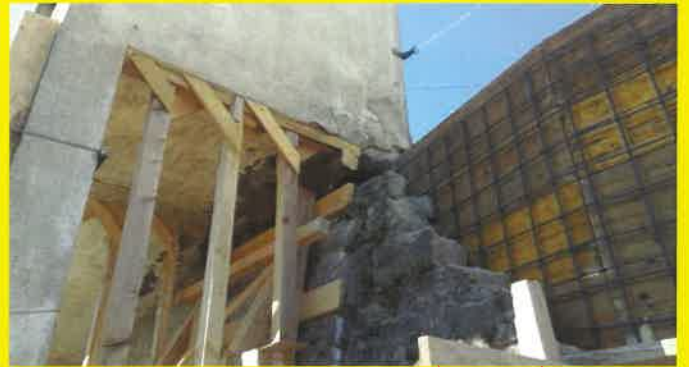
Formando una robusta intelaiatura metallica.
