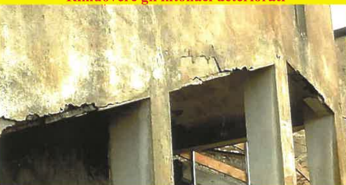
Rinforzare e trattare i ferri delle travature.
