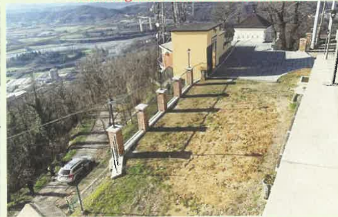
Veduta generale al termine dei lavori
