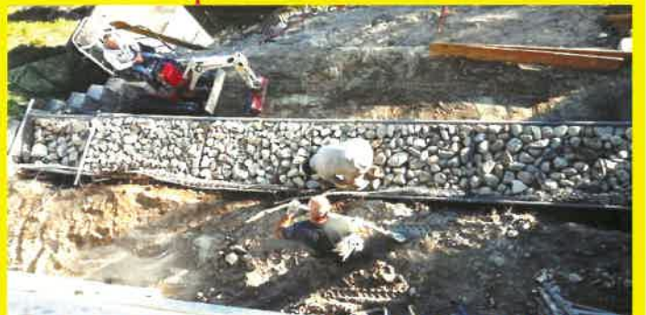
Vengono rimossi e sostituiti da robusti "Gabbioni".
