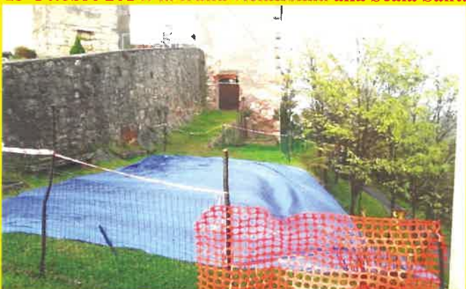
Mettere in sicurezza con teloni per prevenire il peggio.
