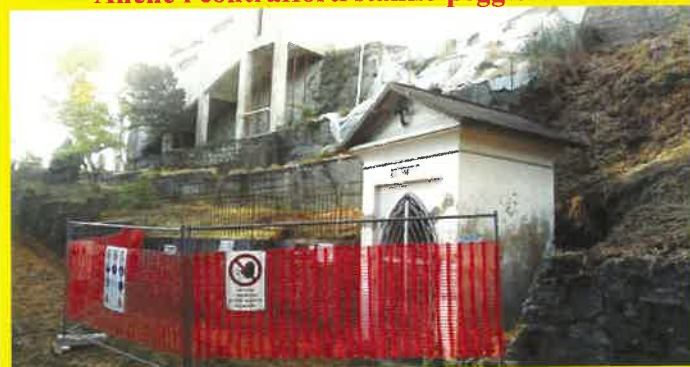
Permessi e pratiche terminate: si apre il cantiere.
