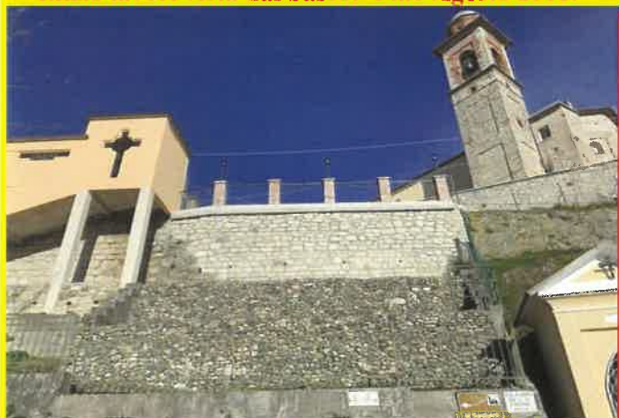
Fine lavori vista dal basso: Ottobre 2019.
