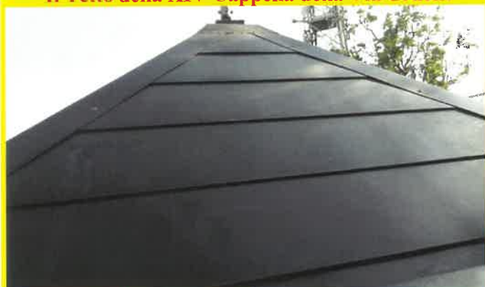
Con la rinnovata copertura.
